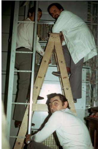
Roger Desplanques supervisant les essais de la maquette du GCI d'arrivée à Marseille
